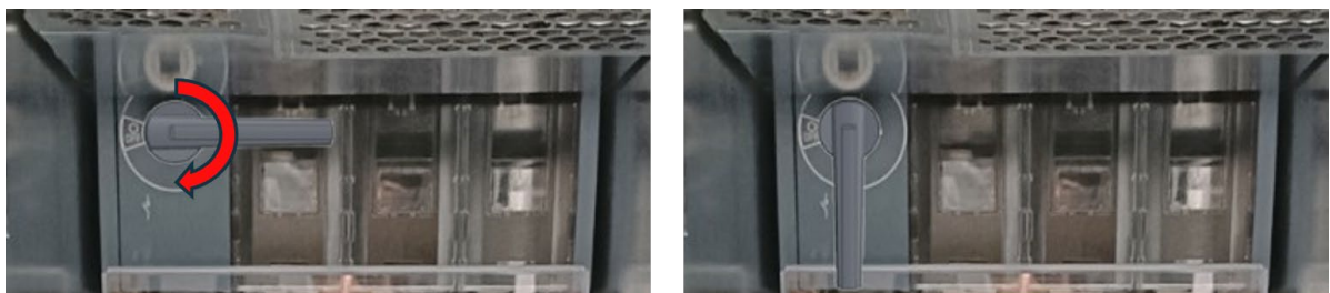
Abbildung 129: Schalten Sie den Hauptschalter ein
