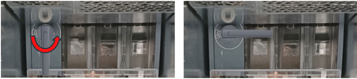
Abbildung 138: Schalten Sie den Hauptschalter aus und sichern Sie ihn
